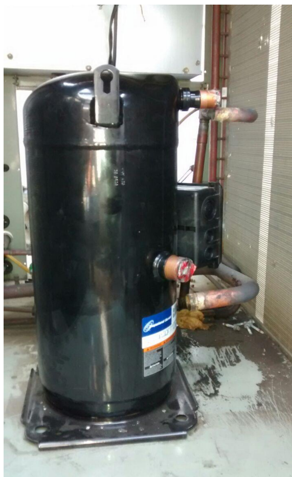
FIGURA 2 COMPRESSOR NOVO E INSTALADO
